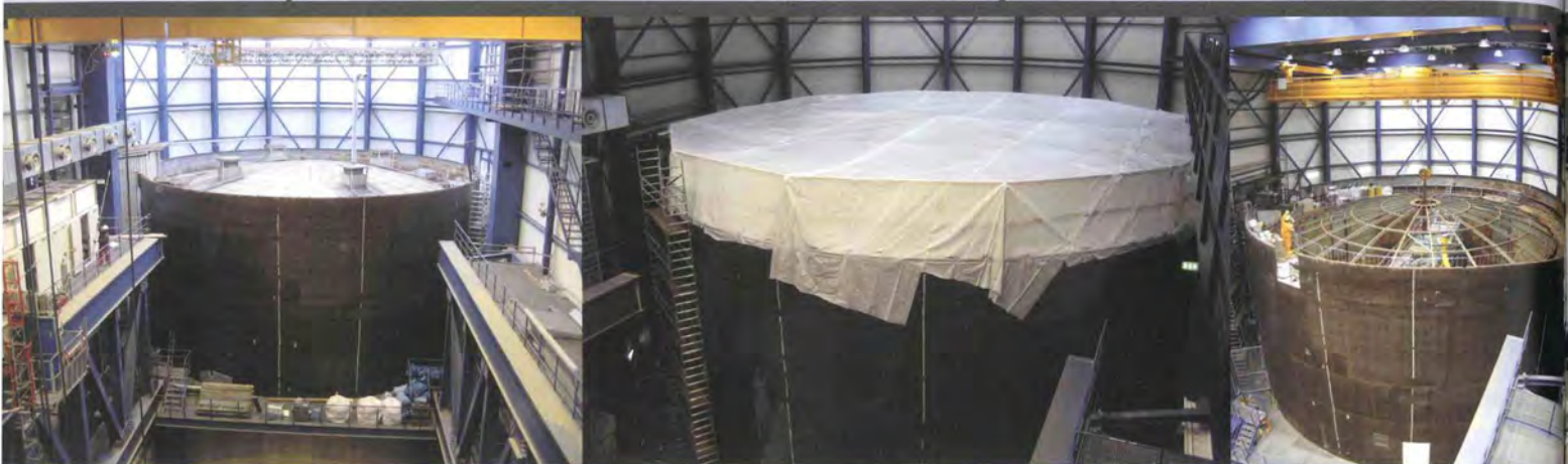
Abbau des Reaktorgebäudedaches unter einem Schutzzelt innerhalb der Materialschleuse
