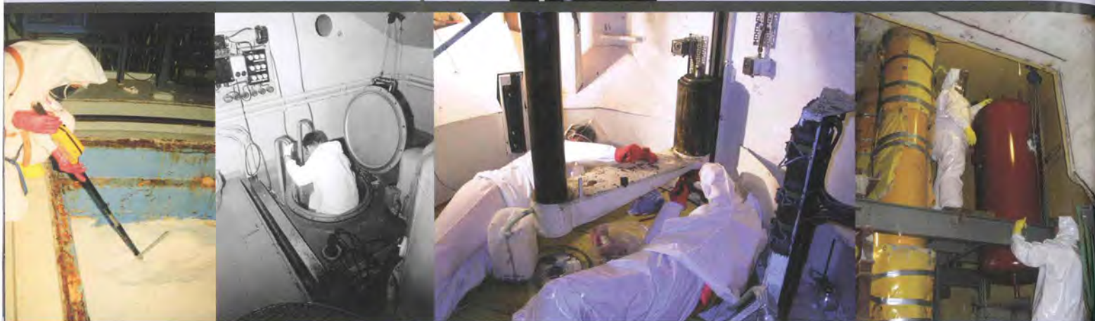
v.l.n.r.: Perliteabsaugung aus den Bodenkammern, Einstieg und Demontagen im Entnahmeraum, Abbau des Ölauffangbehälters
