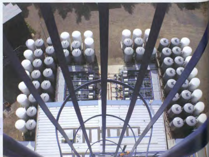
Porenleichtbeton-Silos aus der Vogelperspektive ...
