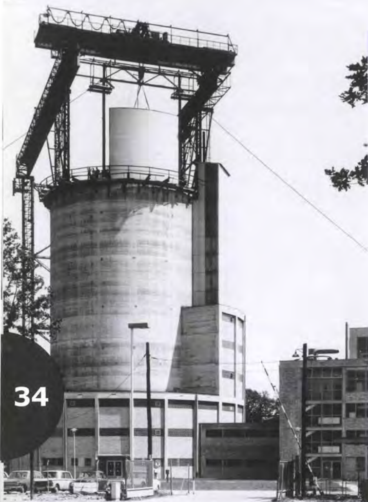
Montage der Wasserhochbehältersegmente
