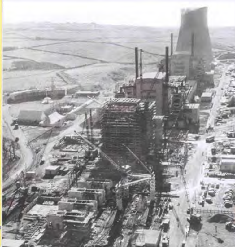
Bau der Calder Hall Reaktoranlage, GB 1956
