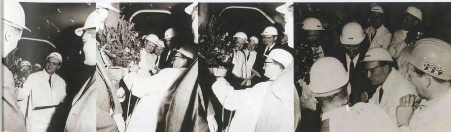
Fertigstellung von Dampferzeuger und Sammlertraggerüst sowie festliche Einweihung durch Herrn Schweiger, seinerzeit Betriebsleiter der AVR GmbH
