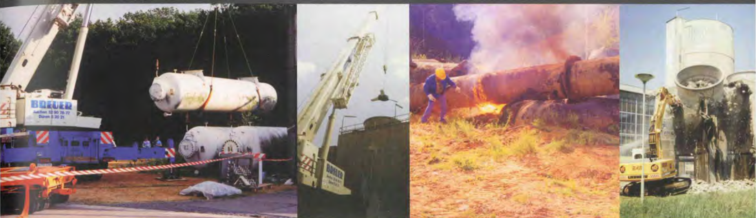
v.l.n.r.: Demontage der Heliumbehälter, der Kühltürme und erdverlegter Kühlwasserleitungen
