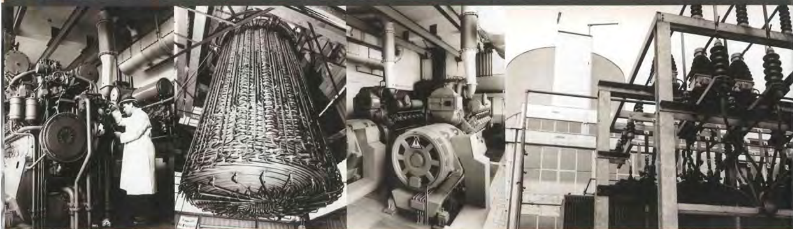
Eindrücke aus der Bauphase des AVR-Reaktors bis zur Stromerzeugung
