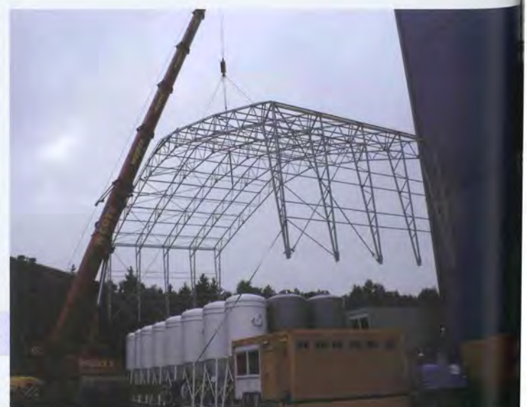
Aufstellung des Zeltgerüsts
