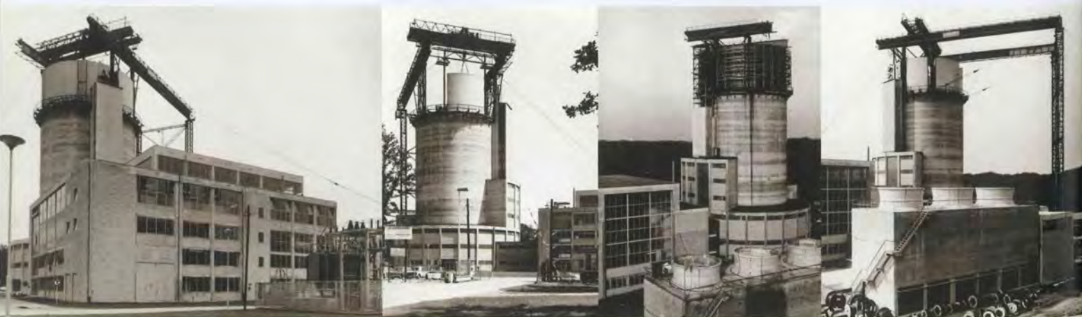
Impressionen aus der Bauphase des AVR-Reaktors
