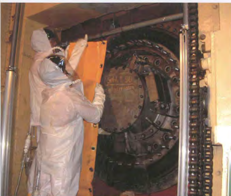
Montage von Bleischutzmatten vor dem Kühlgasgebläse
