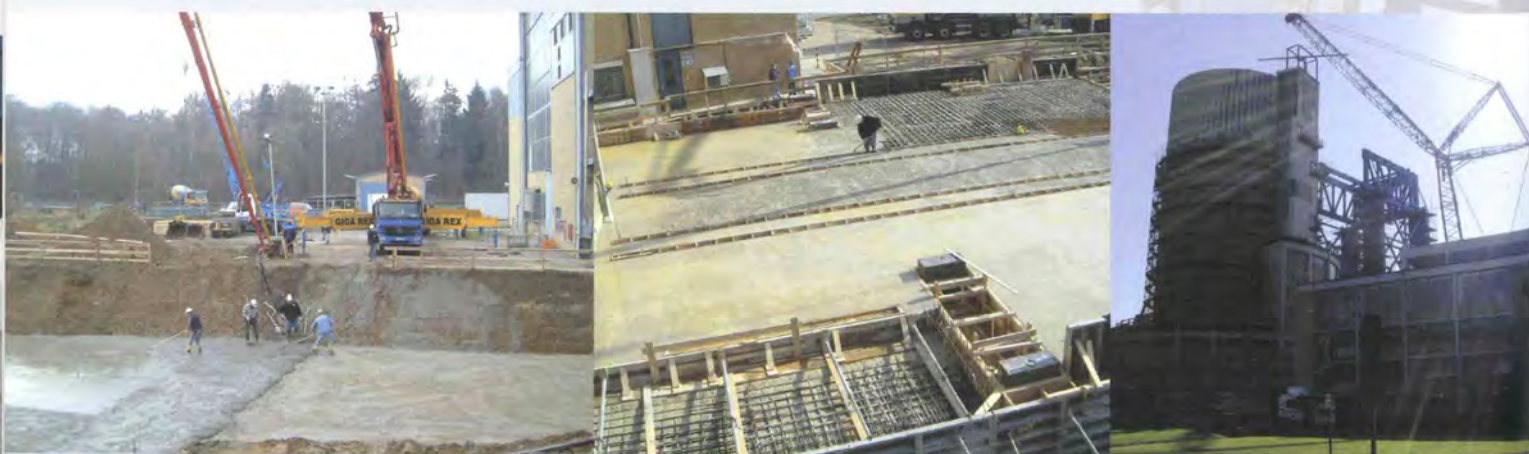
Starke Fundamente zum Bau der Materialschleuse
