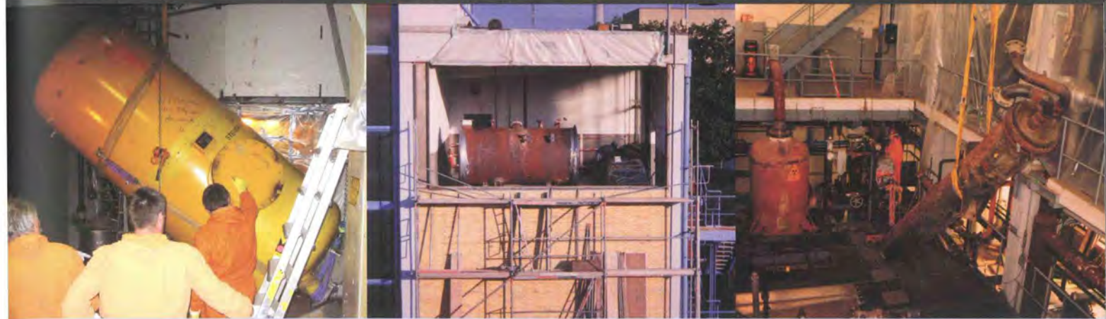
v.l.n.r.: Demontage des Reingaspufferbehälters im Schutzbehälter, Hilfskesselausbau und Abtransport der Wärmetauscher aus dem Maschinenhaus
