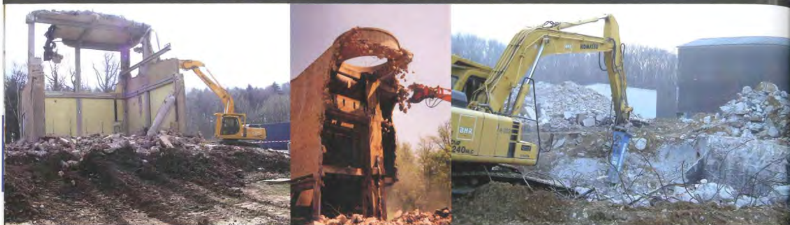
v.l.n.r.: Abriss Pumpenhaus und Kühltürme, Schuttbeseitigung
