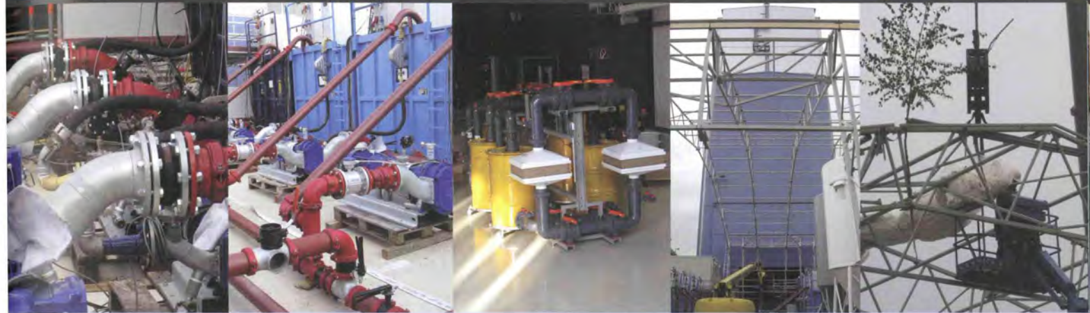
v.l.n.r.: Verfüllpumpen und Misch tanks, Filterstrecke, Gerüst des Schutzzeltes, Montage des Zeltdaches
