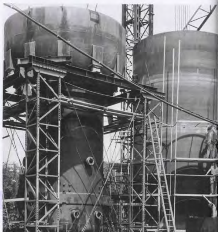
Bau des inneren Reaktorbehälters
