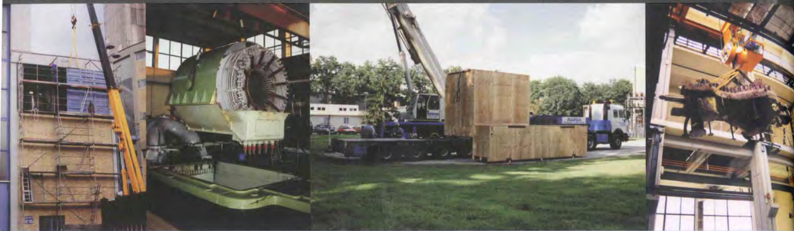
v.l.n.r.: Hilfskesselausbau, Demontage und Abtransport des Generators mit Zubehör, Ausbau des Hochdruckteils des Turbosatzes
